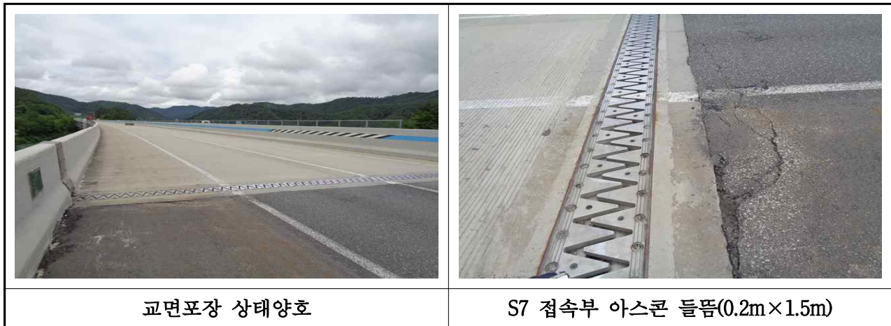
【사진 3.46】 교면포장 손상현황
