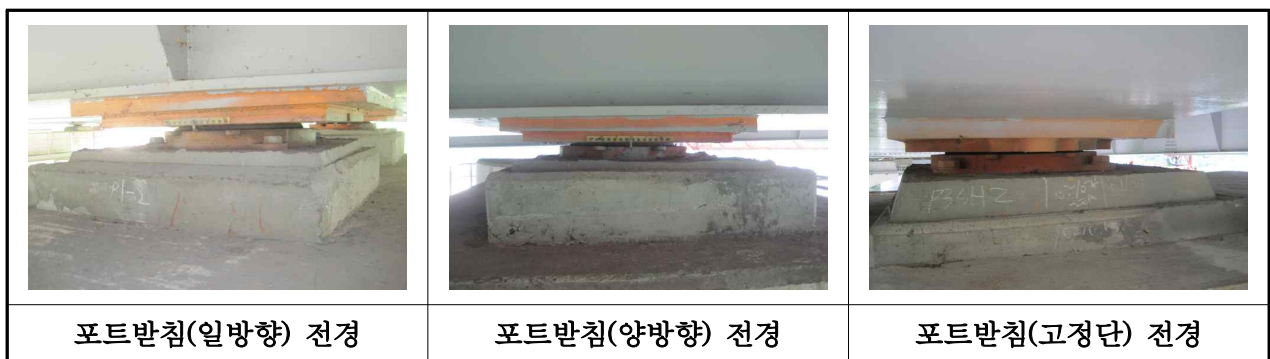
【사진 3.13】 교량받침 전경
