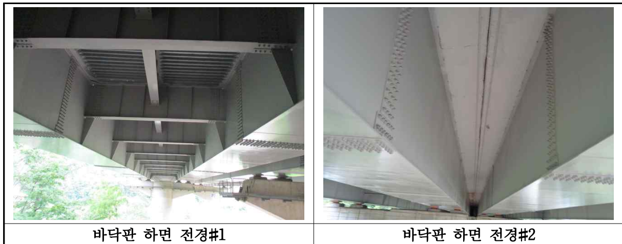
【사진 3.28】바닥판 전경
