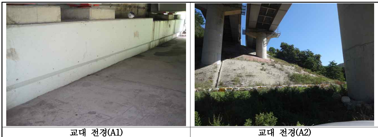
【사진 3.34】 교대 전경
