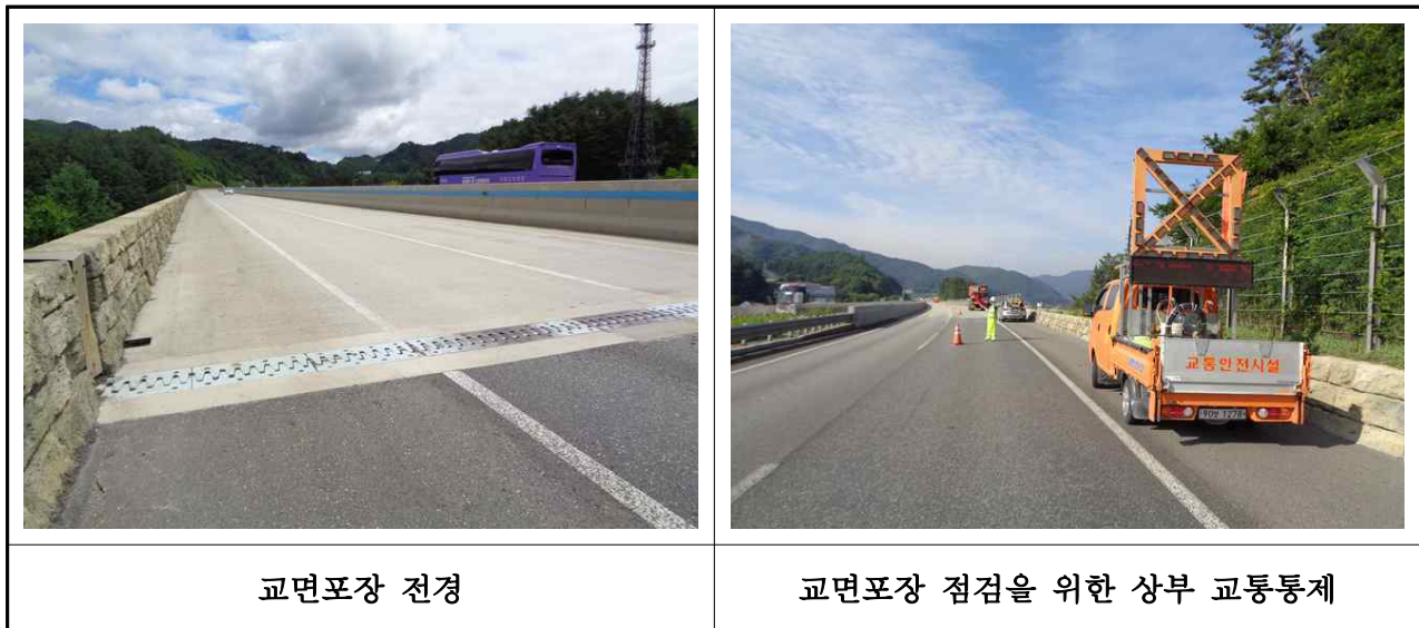
【사진 3.20】 교면포장 전경
