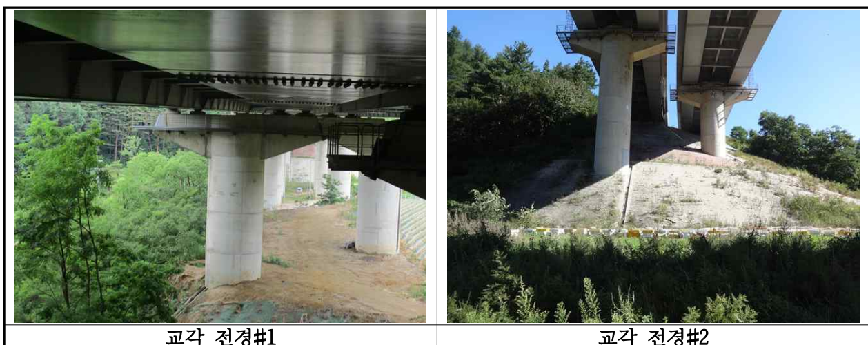
【사진 3.11】 교각 전경
