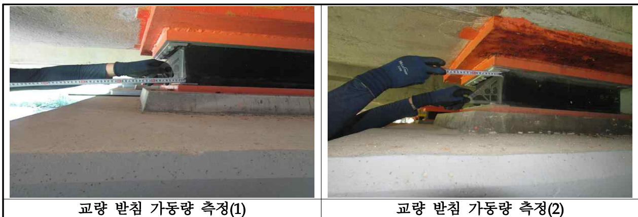
【사진 3.41】 교량받침 이동량 측정
