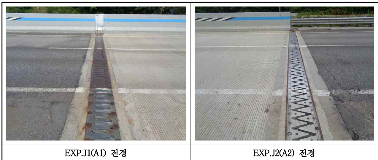
【사진 3.42】 신축이음장치 전경
