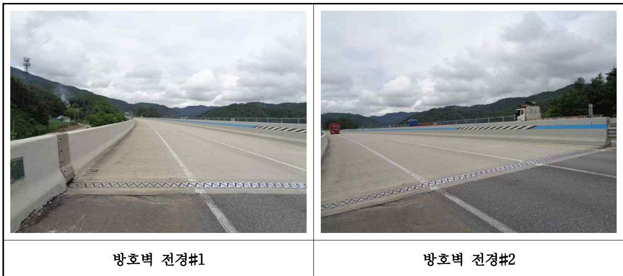
【사진 3.49】 방호벽 및 중앙분리대 전경
