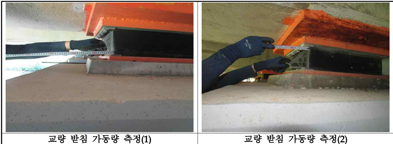
【사진 3.16】 교량받침 이동량 측정
