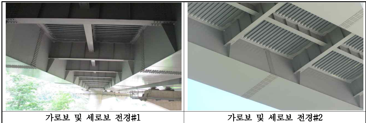
【사진 3.33】 가로보 및 세로보 전경
