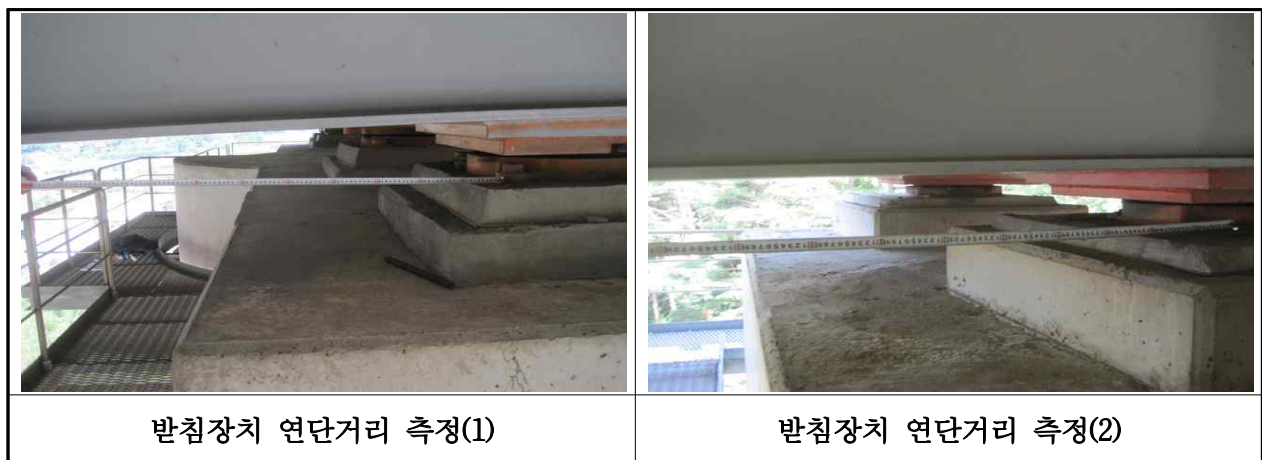
【사진 3.40】 교량받침장치 연단거리측정
