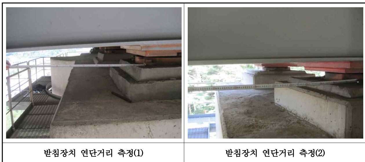
【사진 3.15】 교량받침장치 연단거리측정
