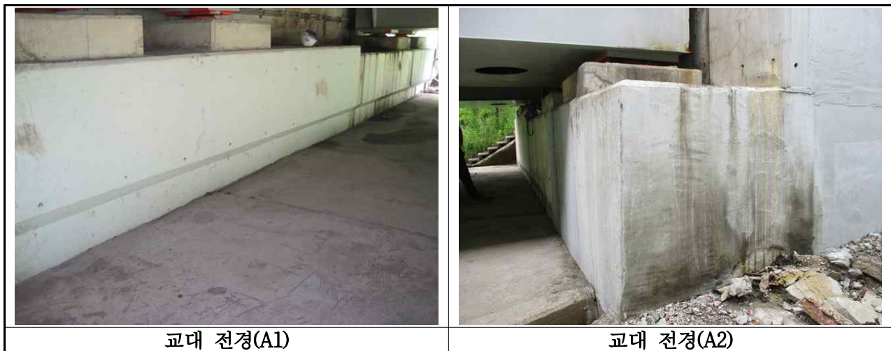
【사진 3.9】 교대 전경
