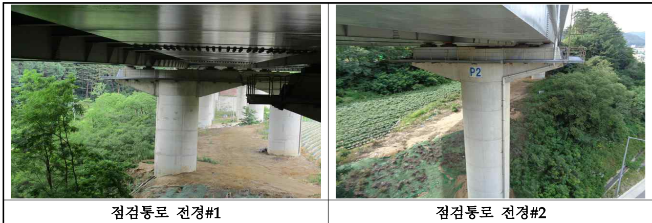
【사진 3.51】 교량 점검시설 전경
