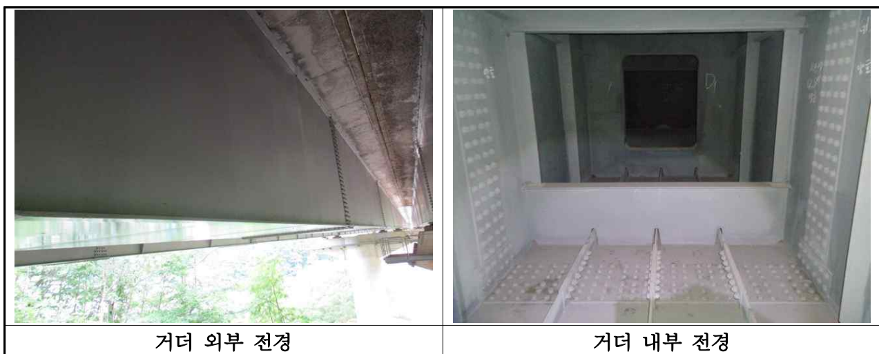
【사진 3.30】 거더 전경
