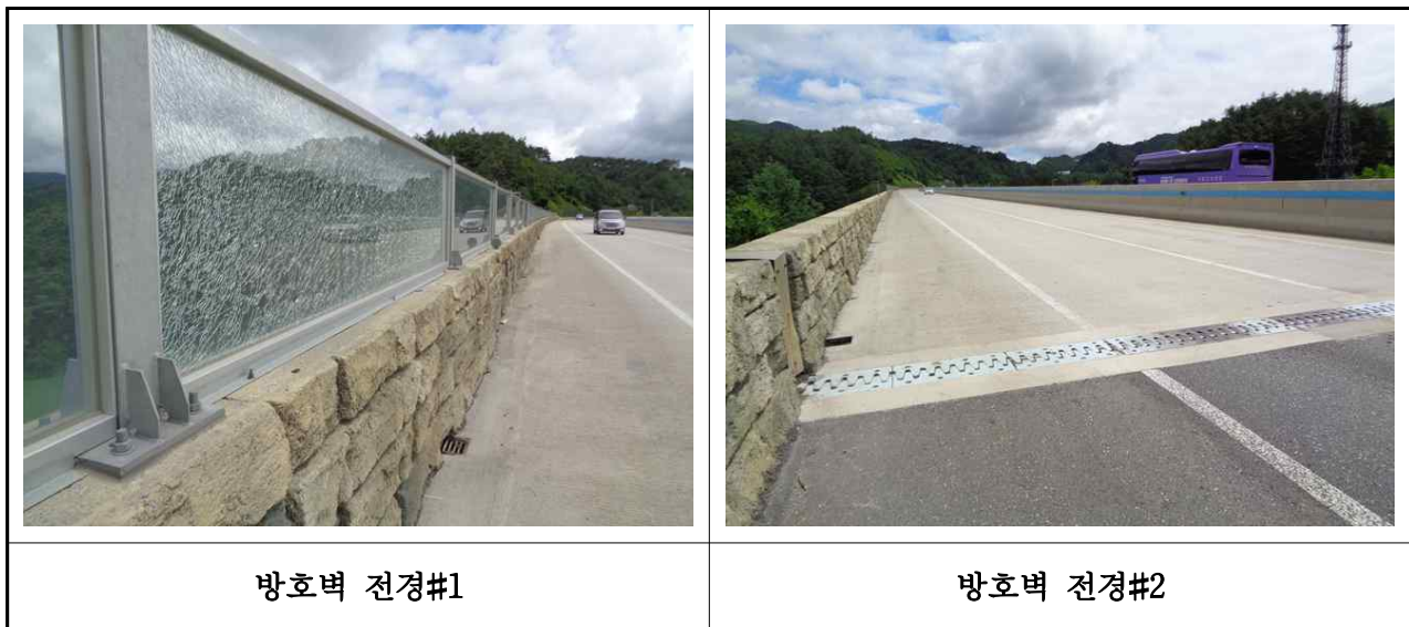
【사진 3.24】 방호벽 및 중앙분리대 전경
