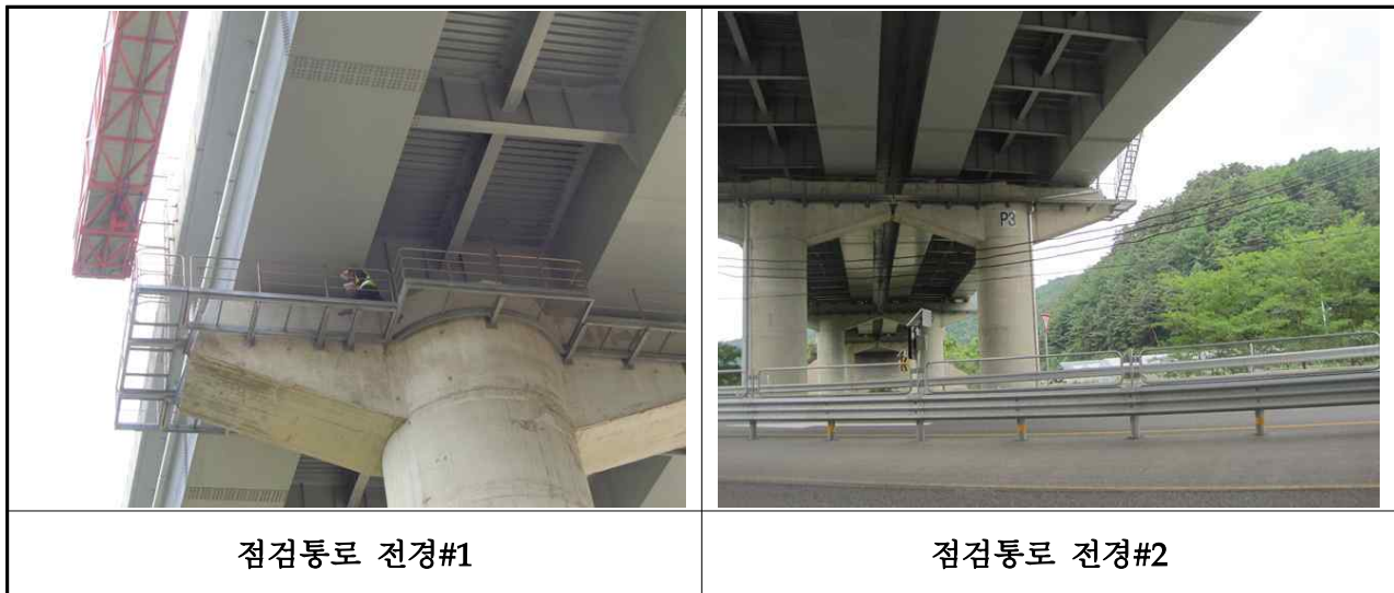
【사진 3.26】 교량 점검시설 전경
