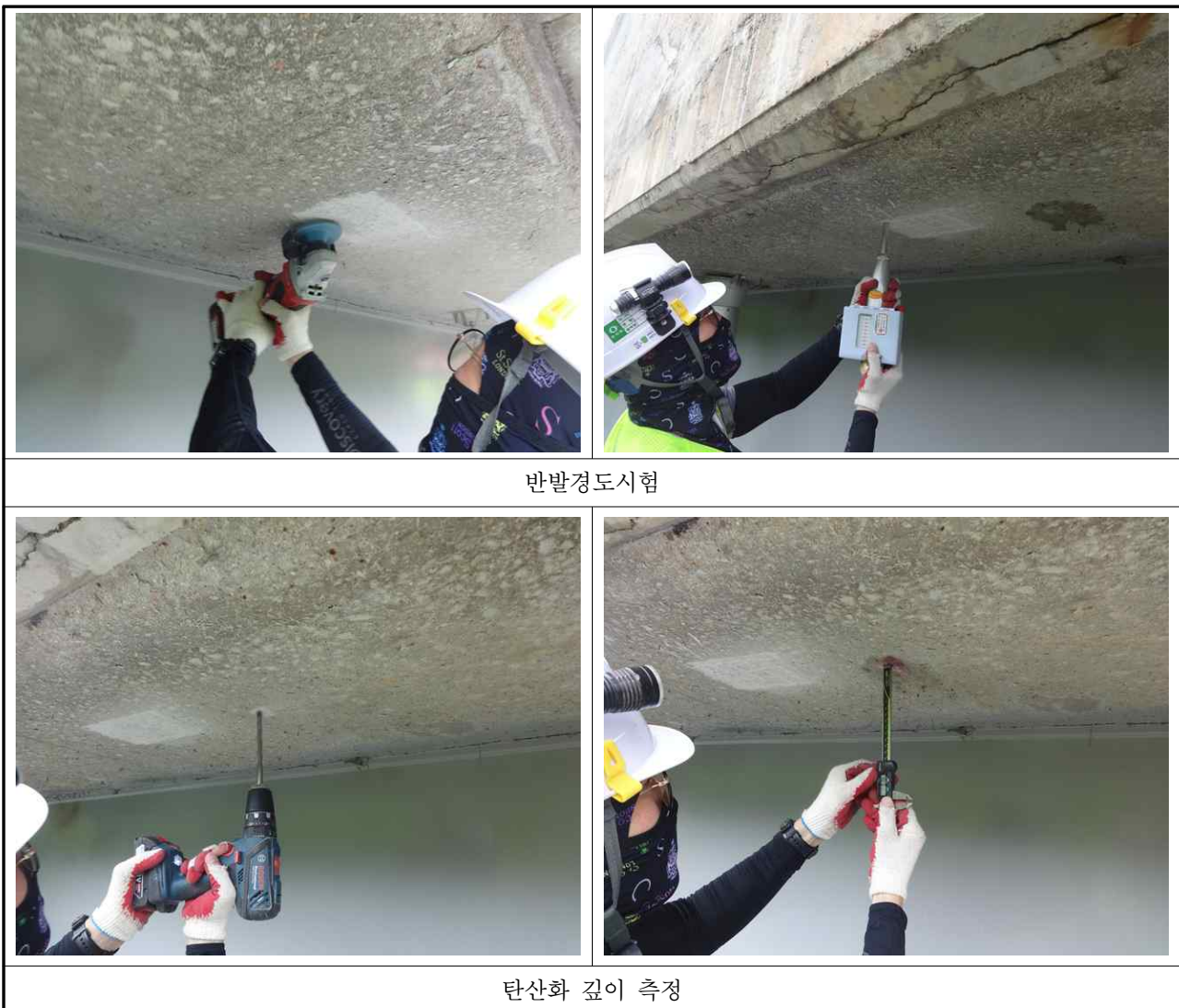
【사진 3.52】 콘크리트 내구성조사 현황
