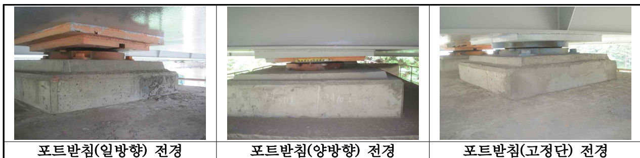
【사진 3.38】 교량받침 전경
