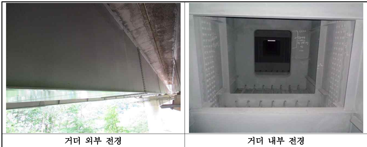
【사진 3.4】 거더 전경
