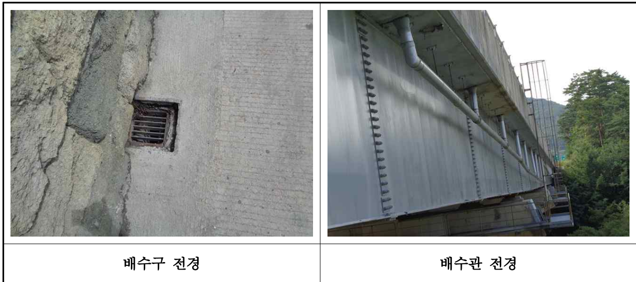
【사진 3.22】 배수시설 전경
